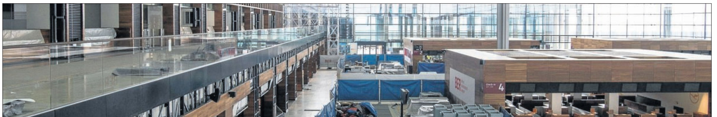
Blick in die Empfangshalle des Pleiten-, Pech- und Panneflughafens: Zum wiederholten Male gibt es Probleme mit der Entrauchungsanlage. Das Bauordnungsamt in Berlin fordert jetzt weitere Nachweise und Nachbesserungen.
